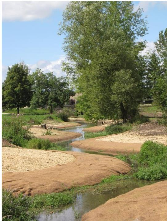
Réalisation de banquettes pour diversifier les écoulements et réduire le lit mineur sur-élargi à Arrelles
